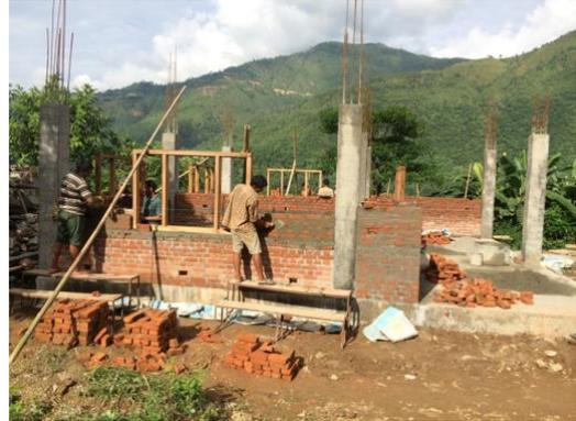
Le deuxième bâtiment est construit avec piliers en RCC Reinforced Cement Concrete (= béton armé) pour pouvoir avoir un étage.
