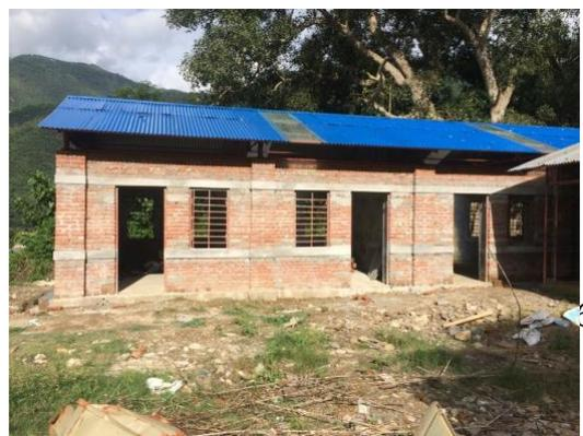
Les techniques de reconstruction diffèrent d'un village à l'autre en fonction du terrain et des structures existantes, mais toutes sont construites de manière antisismique. On essaie bien évidemment de récupérer ce qui peut l'être, comme ci-dessus la structure métallique et les portes et fenêtres.
